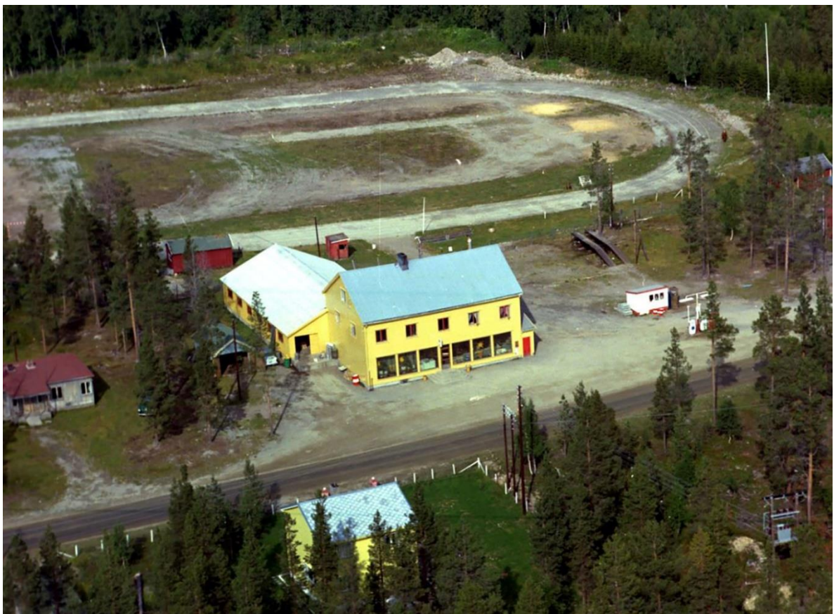
Samvirkelaget på Holt med Jervenbanen bak.
