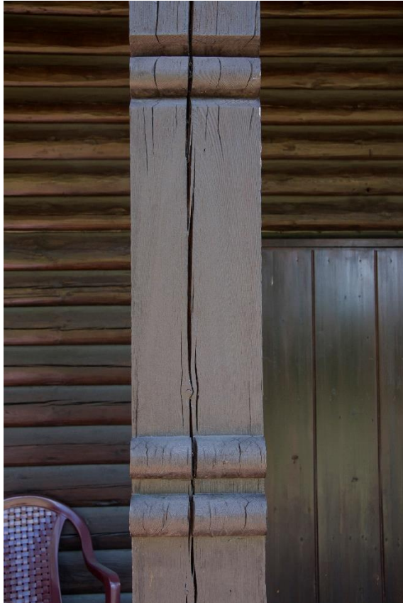
3. til venstre. Del av berande søyle på terrassa. Utsmykking med markant profilering.. til høgre. Langvegg sett mot sør. Viser det solide tømmeret og dei kraftige lafteknutane og rommarkeringa med dekorativ svung nedst.
