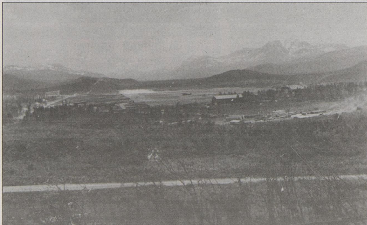
BYGGEPLASS: Oversiktsbilde fra den tyske flybasen på Bardufoss sommeren 1940. Bildet viser at betongrullebanen ble bygget fra øst mot vest. (Foto: Morten Kasbergens arkiv)
